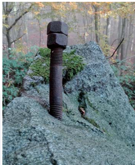
oben: römische Keile zum Spalten des Gesteins, gefunden im Felsberg und ausgestellt im früheren Museum in Beedenkirchen rechts: 1800 Jahre später - Bolzen zum Befestigen von Drahtseilen zum Abtransport von Werkstücken aus den Felsberg-Steinbrüchen der Zeit bis 1979 - Fotos: M. Hiller
