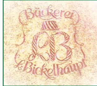
Alte Zeiten: wunderschöne Fassadenarbeit für eine längst vergangene Bäckerei - heutzutage halten Geschäftslogos nicht mehr so lange...
