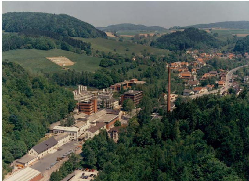
Luftbild von den Lauterter Fabrikanlagen, zur Verfügung gestellt von Familie Meckel, Gadernheim. Zu sehen ist der Zustand vor Niederlegung des Schornsteins, oben links am Wiesenhang das Witterungsversuchsfeld für Farbtafeln. Im Hintergrund sieht man Lautern.
